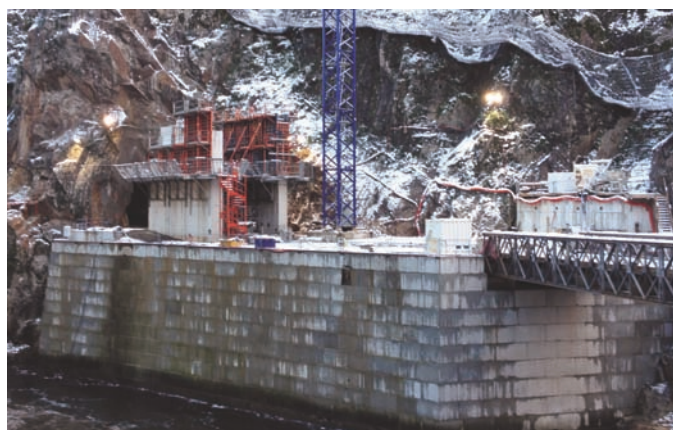
Construction du local d'exploitation.
